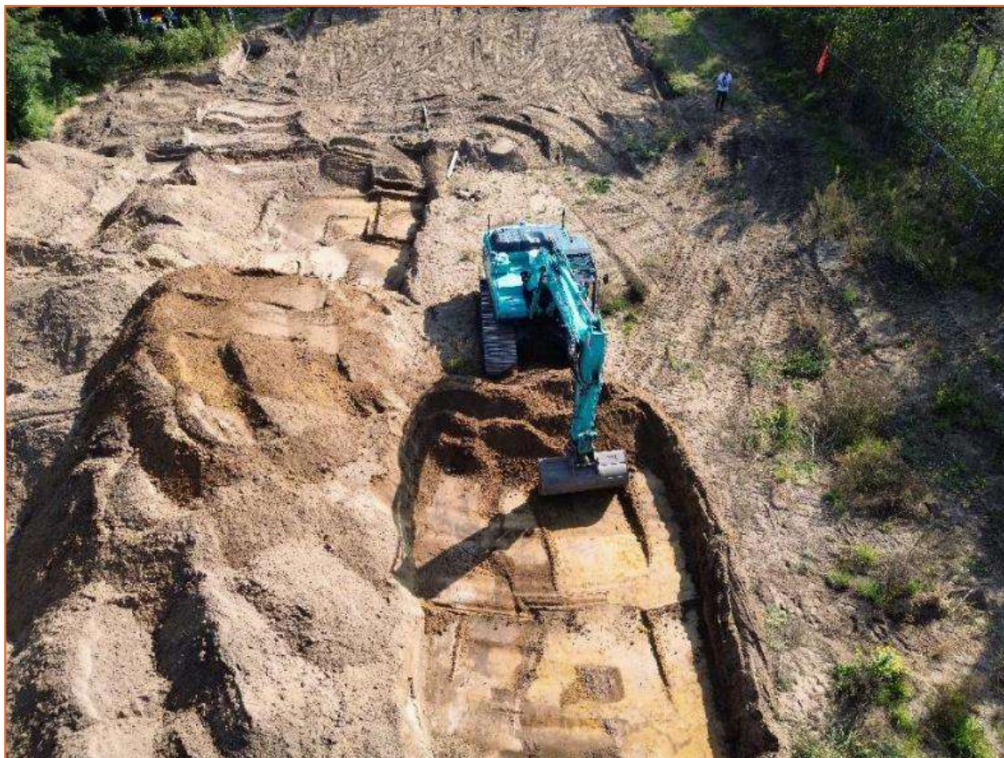
Afbeelding 2: Laagsgewijs detecteren en ontgraven met behulp van een graafmachine. (Bron: Euroradar).
