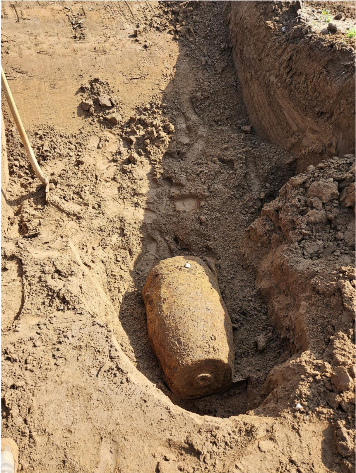
½ bomlichaam (bodem) van 1000lb, MK13 Mod.2 ,zonder ontsteker – met springstof – afgeworpen.
