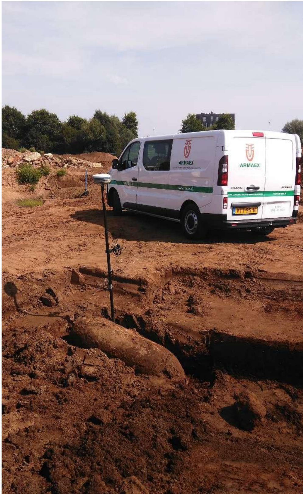
Bom van 1000Lb, MC met neuspistool No. 44 – met veiligheidsskap – niet gewapend – afgeworpen.
