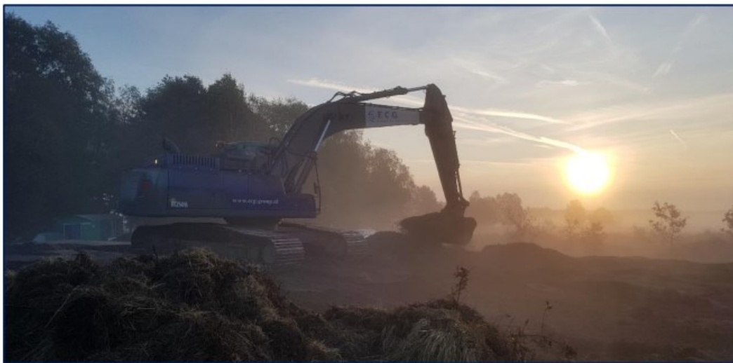
Figuur 3: Gecontroleerd ontgraven.
